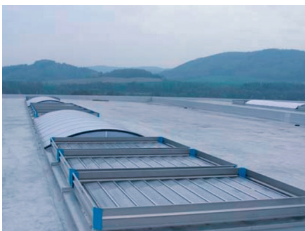
Ort: Koprivnice, Tschechien Objekt: Brose Produktionsstätte
