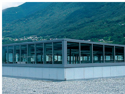
Ort: San Antonino, Schweiz Objekt: Neubau Einkaufszentrum
