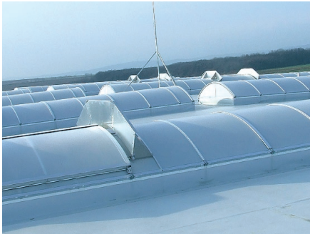
Ort: Bratislava, Slowakei Objekt: Neubau Logistikzentrum
