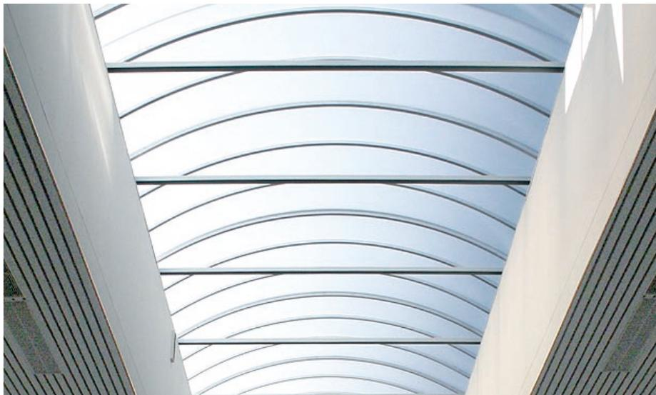
Wir haben uns bei der Entwicklung des CI-System Lichtband B – wie bereits bei dem erfolgreichen Vorgängermodell – erneut sehr auf die Wärmedämmeigenschaften konzentriert. Dafür haben wir ein neues thermisch getrenntes Fußprofil konstruiert, das trotz der Verwendung von Kunststoff höchste Stabilität bietet. Unsere Lösung: Eine Spannkonzole aus Metall, gehalten von einem Fußprofil aus Kunststoff.
