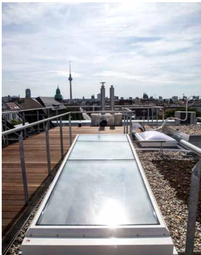
Dachausstiege ermöglichen den einfachen Zutritt aus dem Gebäudeinneren auf das Dach. So auch der Flachdach Ausstieg Komfort Solo für exklusive Dachgeschosswohnungen.
