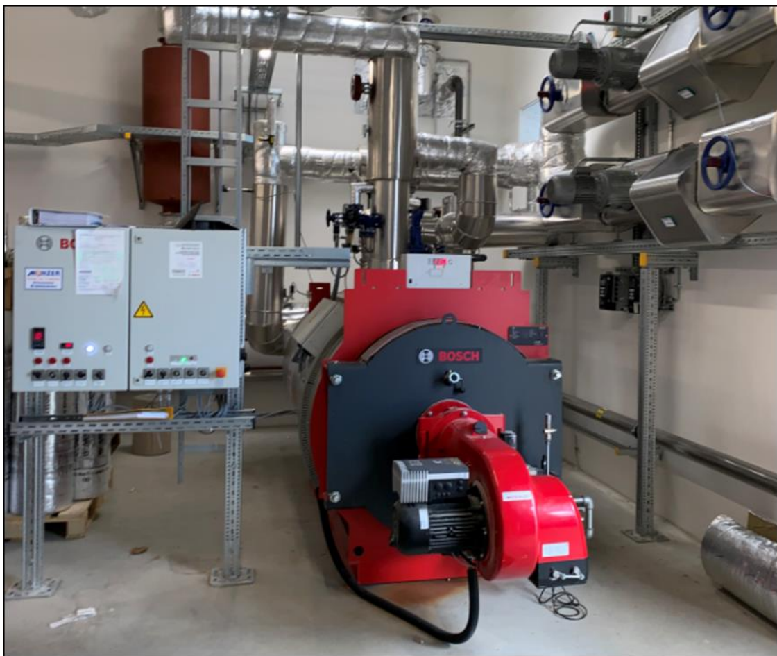
Abbildung 33: Der Heißwasserkessel von Anlage 12
