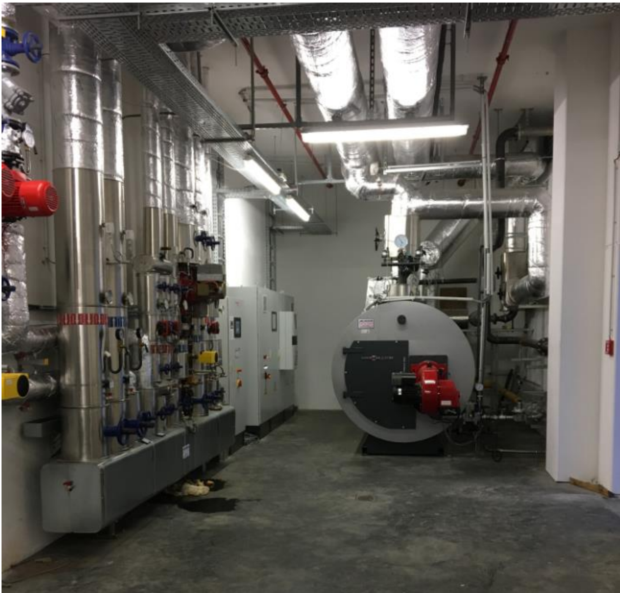
Abbildung 24: Der Heizkreisverteiler mit Heißwasserkessel von Anlage 11
