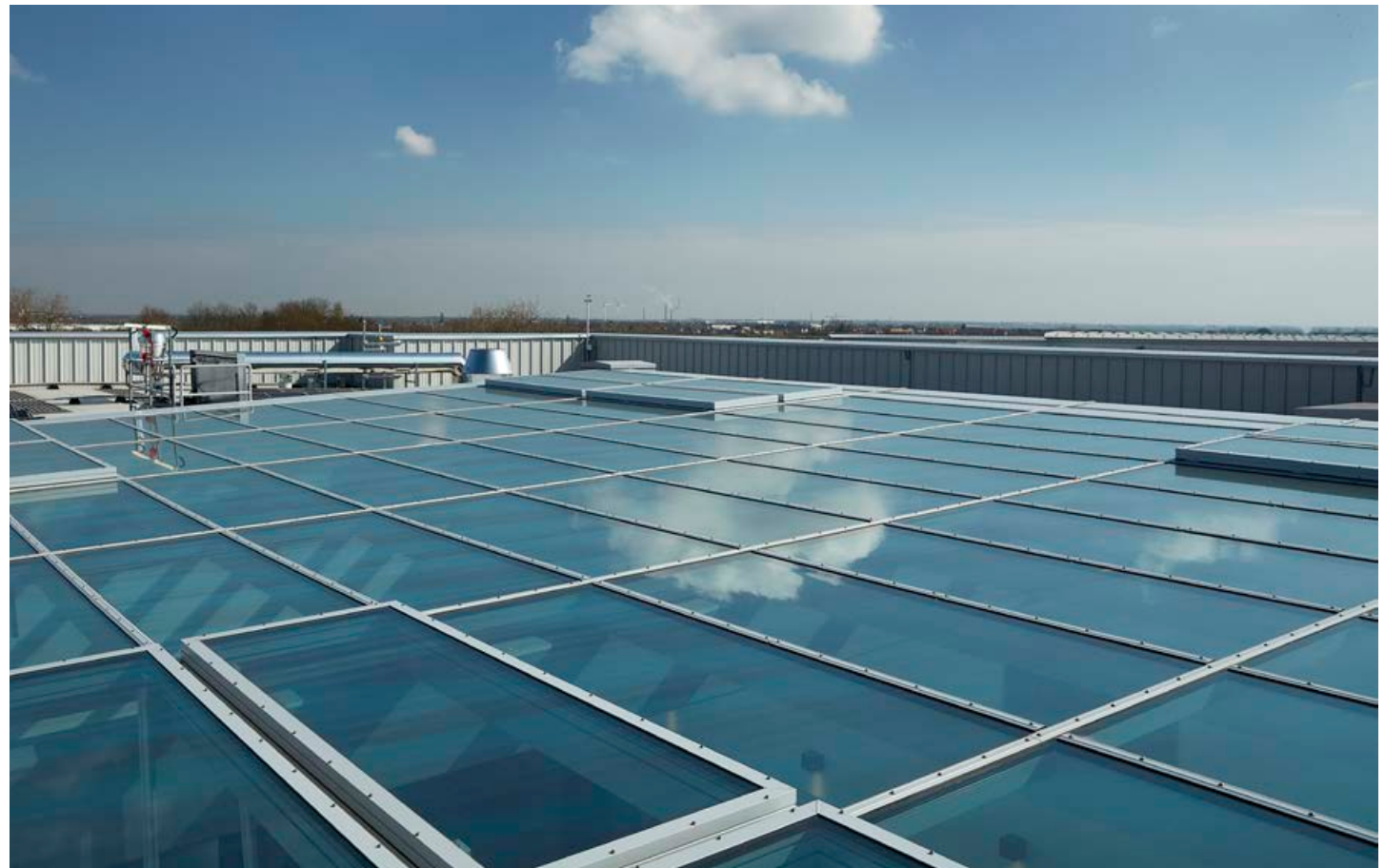
LAMILUX Glasdach PR60 auf dem Flachdach von „British Sugar“, England
