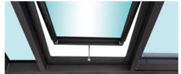
Lüftungsflügel mit verdecktem Kettenschubmotor
