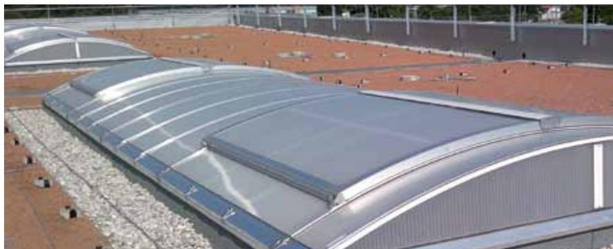
Die „Wiener Linien“ sanieren die Flachdächer ihres gigantischen Betriebs- und Instandsetzungsdepots: **LAMILUX konstruiert, liefert und montiert 364 Tageslichtsysteme vom Typ LAMILUX CI-System Lichtband B** – insgesamt 3.200 laufende Meter – mit 390 integrierten Klappensystemen für den Rauch- und Wärmeabzug. Darüber hinaus liegt in den Händen von LAMILUX die Konzeption und Installation der **RWA-Steuerungs- und Automationstechnik**.
