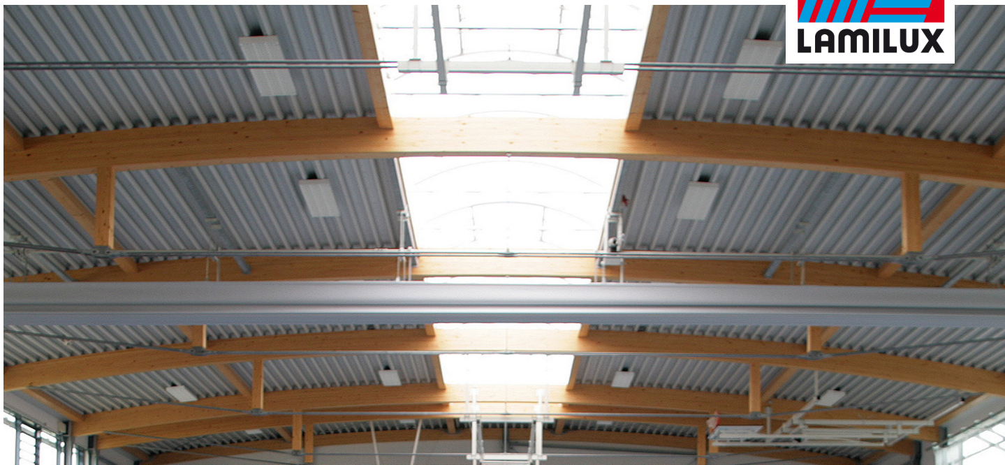
Sporthalle Mittelschule Adorf
